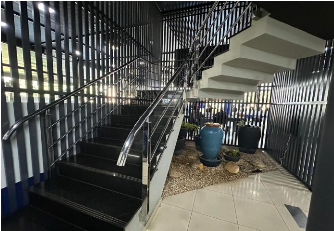
Escadas de acesso ao mesanino
