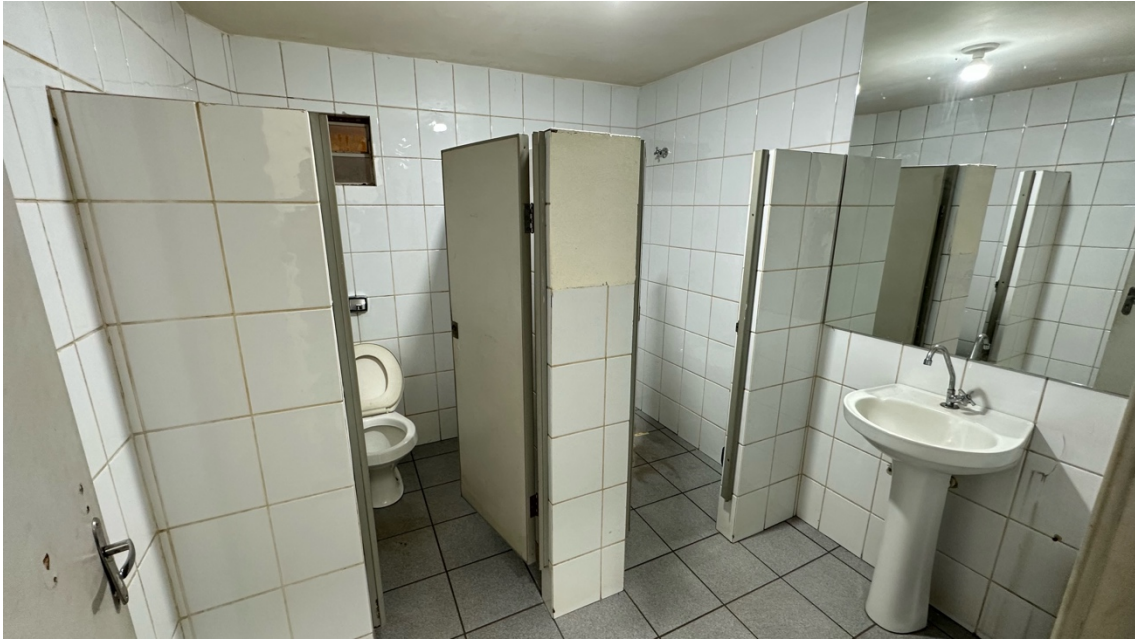
IMAGEM 36 – BANHEIROS DA PARTE DOS FUNDOS DA EDIFICAÇÃO
