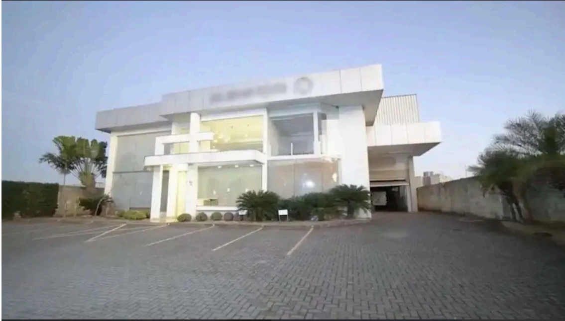
IMAGEM 1 DA AMOSTRA 4 – FACHADA DO IMÓVEL
