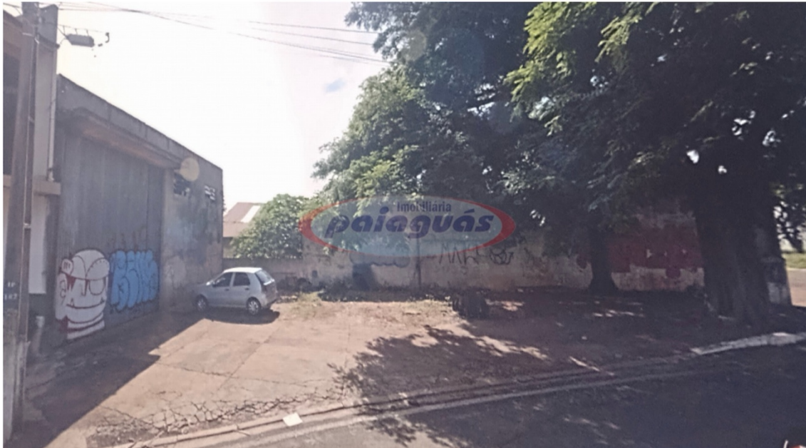
IMAGEM 2 DA AMOSTRA 1 – FACHADA DO IMÓVEL
