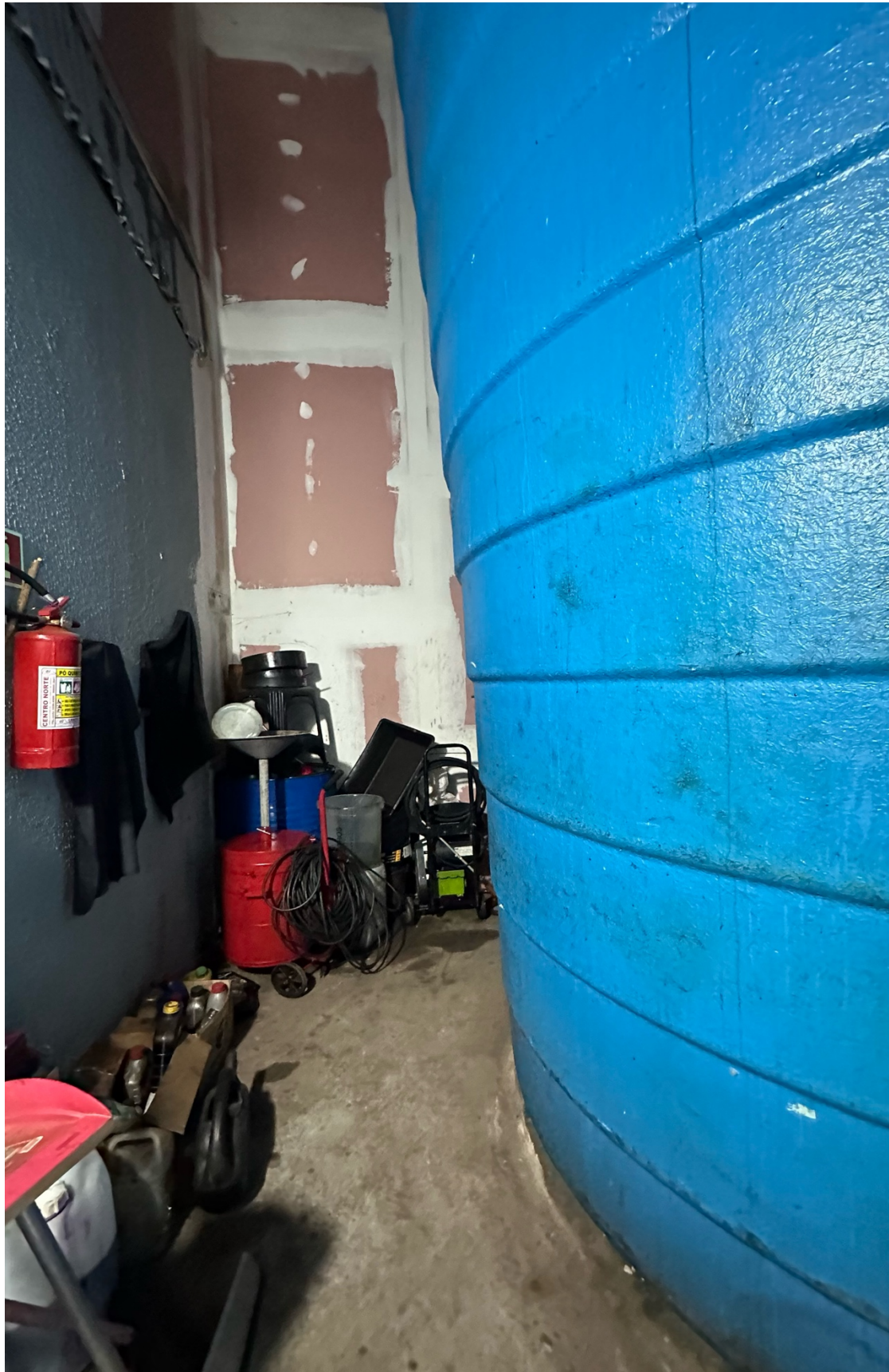
IMAGEM 20 – CAIXA D'ÁGUA DE ALVENARIA EXTERNA
