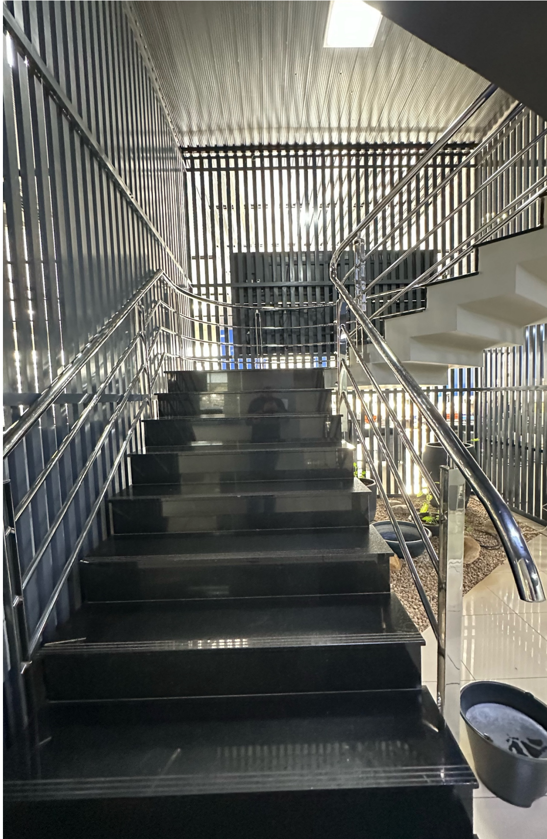
IMAGEM 22 – ESCADA DE ACESSO AO MEZANINO
