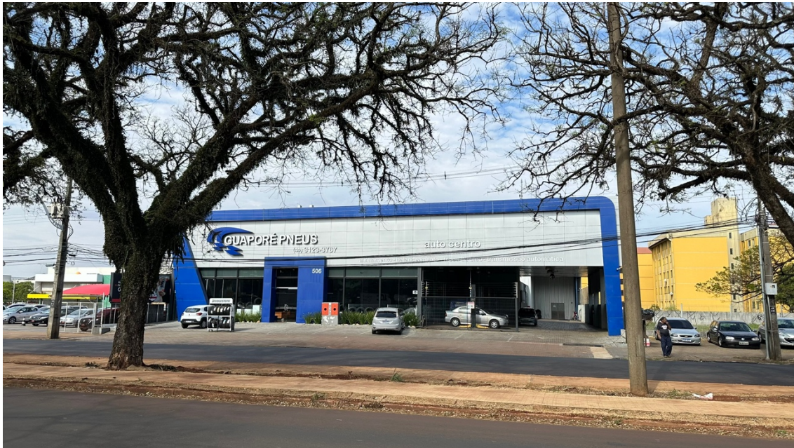
IMAGEM 5 – FACHADA DO IMÓVEL
