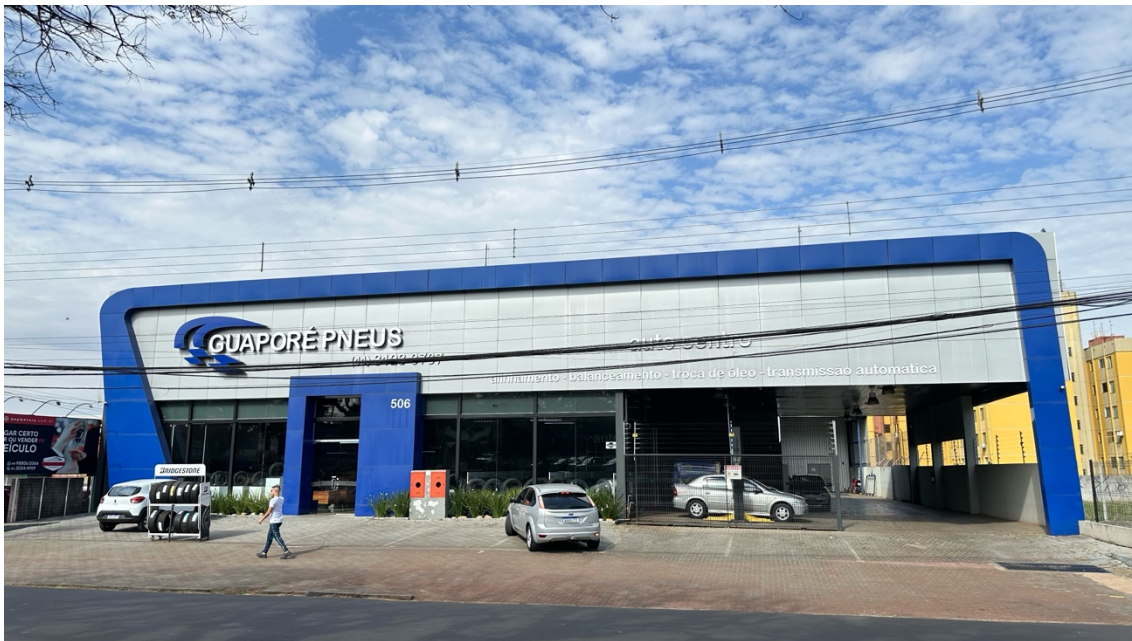
IMAGEM 6 – FACHADA DO IMÓVEL
