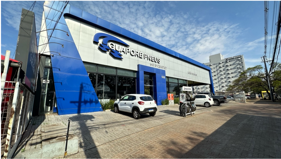
IMAGEM 7 – FACHADA DO IMÓVEL LADO ESQUERDO
